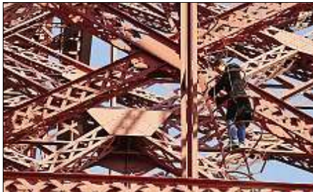
VERTIGINEUX. Le viaduc possède un réseau de passerelles et d'échelles destinées avant tout à son entretien.
